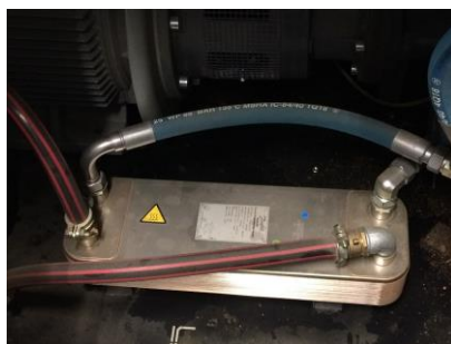
Echangeur sur huile du compresseur
