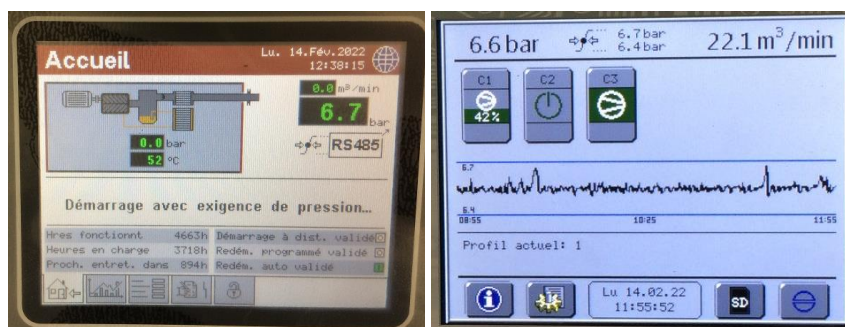
Régulation des compresseurs
